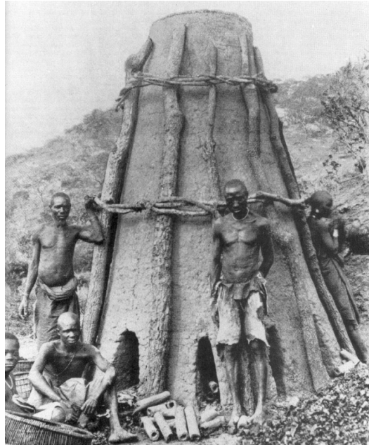
Bild 3.3: Eisenherstellung in Afrika um das Ende des 19. Jahrhunderts.
